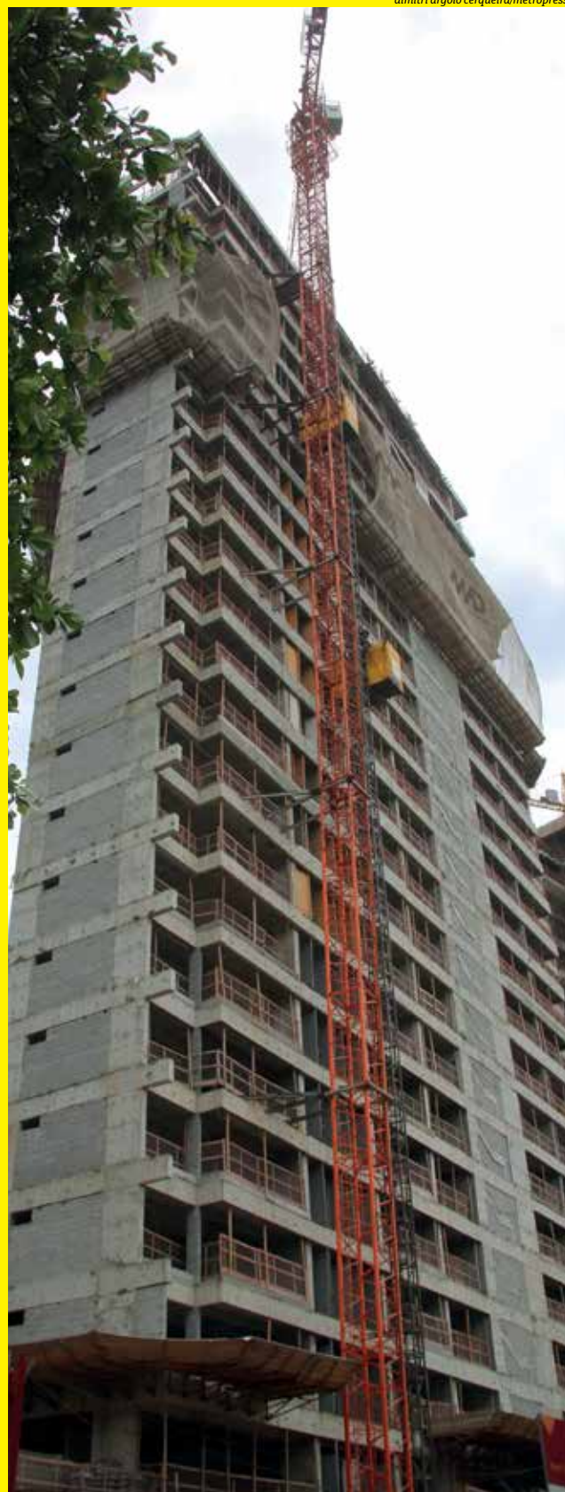
Prédio em construção da Moura Dubeux, na orla de Ondina
